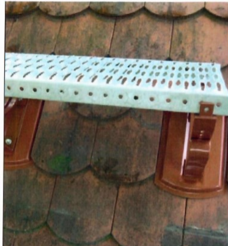
10. Pohled na kompletní usazenou plošinu do krytiny ve tvaru bobrovky šupinové pokládky.
