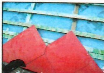
popis 2 Připravená krytina poro montáž univerzálních šablon pro stoupací plošinu
