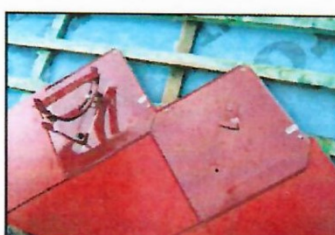
popis 9 Pohled na postupnou montáž podpěr pro stoupací plošinu
