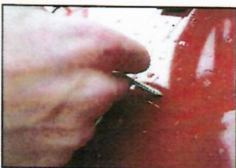
popis 7 Šroub pro přichycení podpěry který je velmi důležitý pro pevnost podpěry
