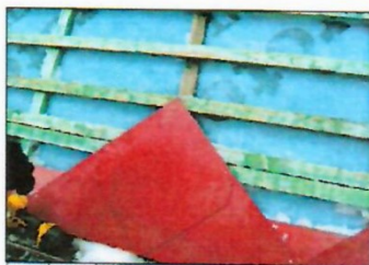
popis 1 Montáž přidavné latě pro připevnění stoupací plošiny
