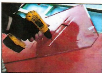
popis 4 Předvrtání pro šroub pro připevnění podpěry.
