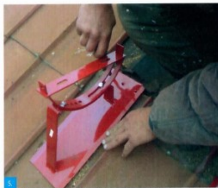
5. Plotnu k č.1 přišroubojeme třemi vrutí (přiložené k plotně v balení) proti vytažení z drážky v bednění.
