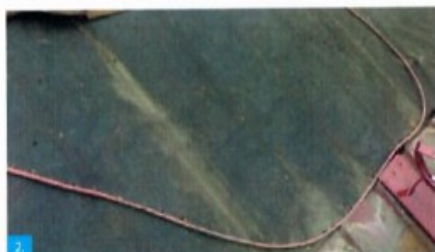
2. Odskrytí střešní krytiny (zde plechová panelka) pro montáž plotny č.1 (případně nášlapu č. 2 nebo univerzální šablony č. 36).
