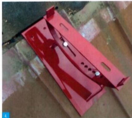
4. Uložení plotny do připravené drážky nebo je možné využít mezery mezi prkny. Tato drážka je nutná pro větší nosnost a bezpečnost plotny.
