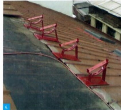
6. Pohled na připravené podpěry pro stoupací plošinu. Tyto podpěry musí být namontovány od sebe ve vzdálenosti maximálně 1200 mm pro nosnost 120 kg. Plošiny PLATON jsou pro toto zatížení vyráběny a byly provedeny i starické zkoušky.
