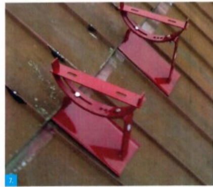
7. Překrytí ploten původní krytinou je výhodnější provést ještě před montáží plošiny pro lepší přístup ke krytině.
